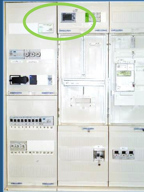
Feldversuch mit in Elektroverteilung eingebautem Consolinno Leaflet und Modbus Zähler
